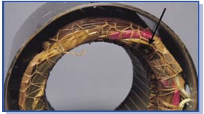
Este devanado fue causado por un pico de Tensión. Una prueba de aislamiento no lo detectaría!
